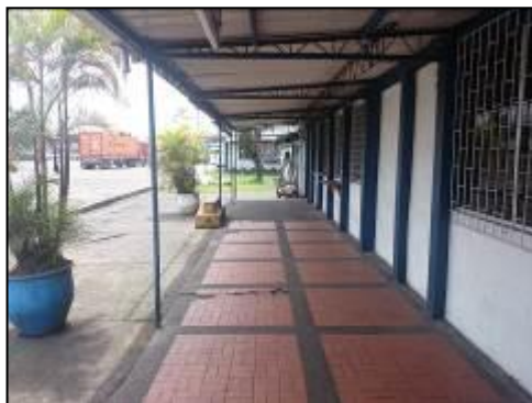
Pasillo para el punto de encuentro
